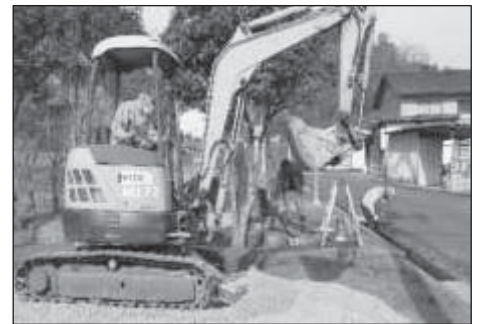
駐車場新設工事
