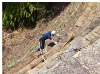
鳶ヶ迫砂留整備 4 月
