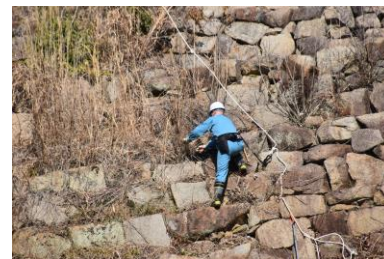
鳶ヶ迫砂留の草とり整備
