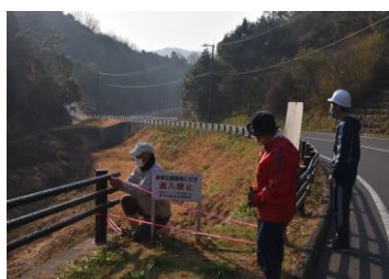
猪に掘り起こされた場の復元作業
