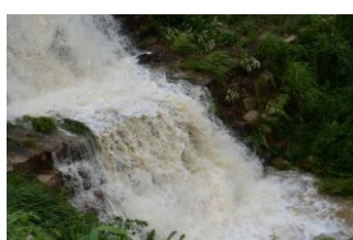
6番砂留基礎部
