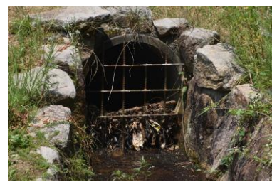
内広砂留⇒堂々公園出口のごみ清掃
