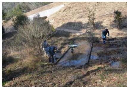
6番砂留下の橋整備
